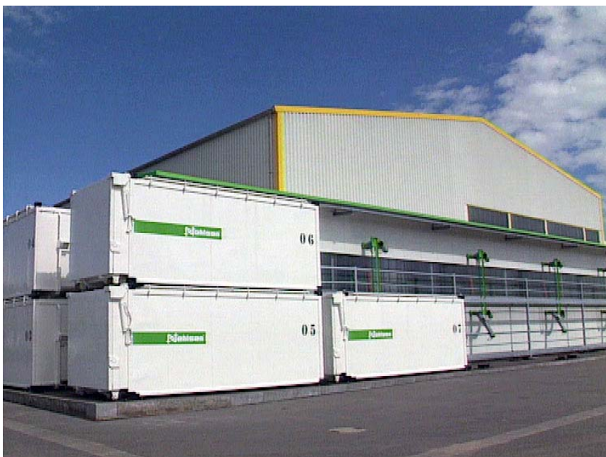
Nehlsen-MBS Container zur biologischen Stabilisierung
