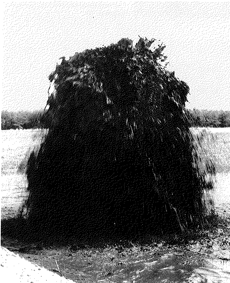
Bild 5 Nach dem Initialeintrag entstehen infolge Eigengewicht der überlagernden Schichten im Untergrund enorme Porenwasserüberdrücke, die sich oftmals in Form von Wasserfontänen an der Oberfläche bis zu 30 Minuten lang abbauen. Dies erfolgt meist über die Sprengbohrlöcher (im Bild).
