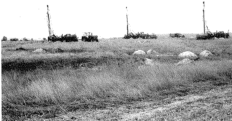
Bild 2 Abteufen der Sprengbohrlöcher in einem bestimmten Raster Im Vordergrund Aushubmassen aus den Bohrspülungsgruben; im Hintergrund Drucksonde im Einsatz.
