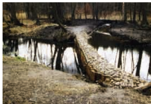
Bild 2.5: Noch nicht fertiggestellte Buhne mit Steinschüttung – im Hintergrund die Mündung in den ausgehobenen Mäander (K. LIESKE 2002)
