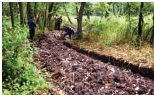
Bild 2.4: Per Hand ausgeführte Aushubarbeiten an einem Altmäander (K. LIESKE 2002)
