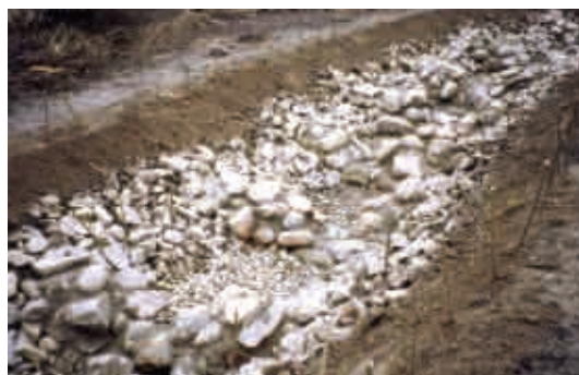
Bild 2.14: Umgehungsgerinne Eichendorfer Mühle im Bau, mit bei Fließgeschwindigkeiten größer als 1 m/s erforderlichen Sohlenbefestigungen (F. KRÜGER 1992)
