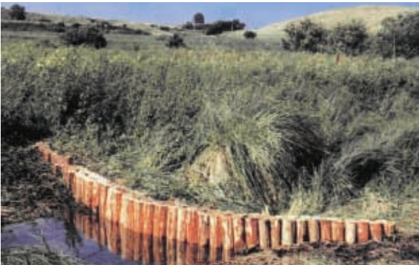
Bild 2.34: Stauwehrranlage (H. STEGMANN)
