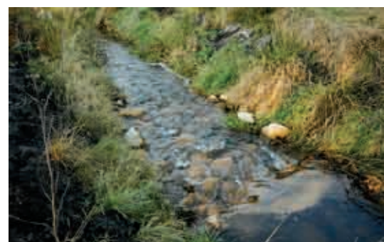
Bild 2.10: Riembach mit eingebauter Sohlgleite (U. ALEX)
