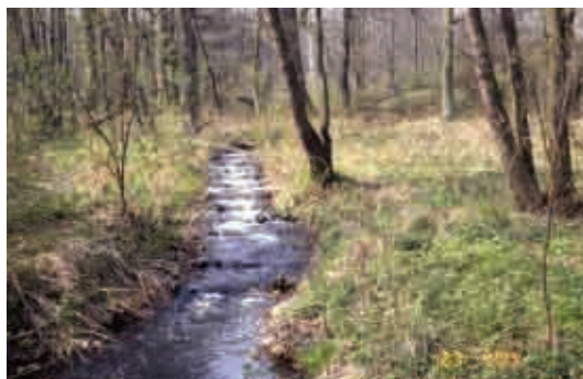
Bild 2.15: Umgehungsgerinne Eichendorfer Mühle nach Fertigstellung, mit maximalen Fließgeschwindigkeiten von ca. 1,4 bis 1,6 m/s beim Überströmen der Schwellen und unter 0,5 m/s in den Becken (F. KRÜGER 04/94)
