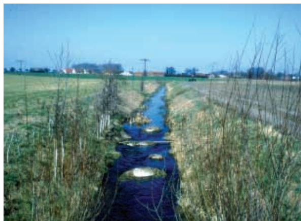
Bild 2.55: Künstlich ausgebautes Regelprofil mit neu angelegter Sohlgleite südlich der Ortschaft Demnitz (J. GELBRECHT 2001)
