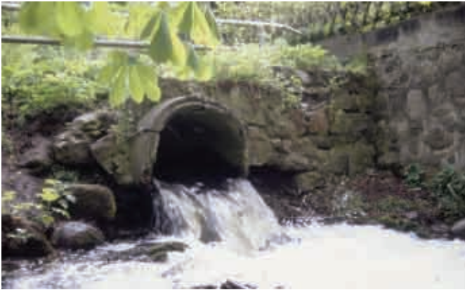
Bild 2.16: Vor dem Umbau durch ein Betonrohr mit aufgesetztem Staukopf gebildeter Mühlenstau an der Pritzhagener Mühle (F. KRÜGER, Frühjahr 1994)
