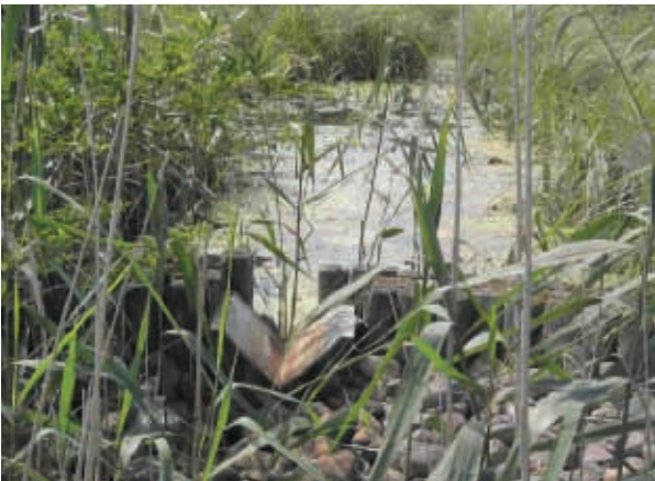
Bild 2.35: Stauanlage mit eingebautem Überlauf (L. LANDGRAF 08/03)
