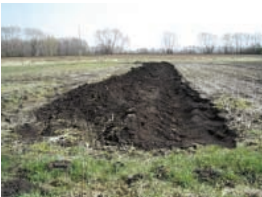
Bild 1.3.6: Muldenentwässerung im Spreewald (K. RUCH 05/03)
