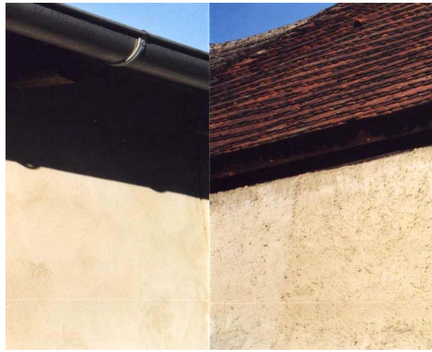
Abb. 65: Gegensatz zwischen strukturierter und unstrukturierter verputzter Hauswand
