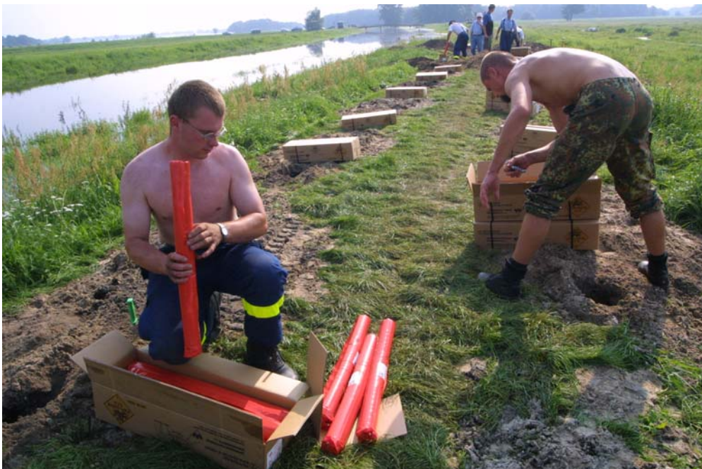
Polder "Flöthgraben" am 22.08.02, 16:15 Uhr: Die Bohrlöcher auf der Deichkrone werden mit Sprengstoff gefüllt.
