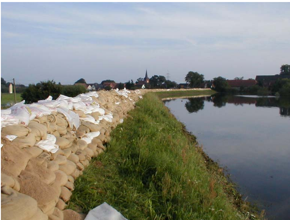
Kurz vor dem Ortseingang von Bälow (Amt Lenzen-Elbtalaue, Prignitz) am 25.08.02: Kreisstraße und Deichhinterland sind durch Sandsackaufkadungen ausreichend geschützt.
