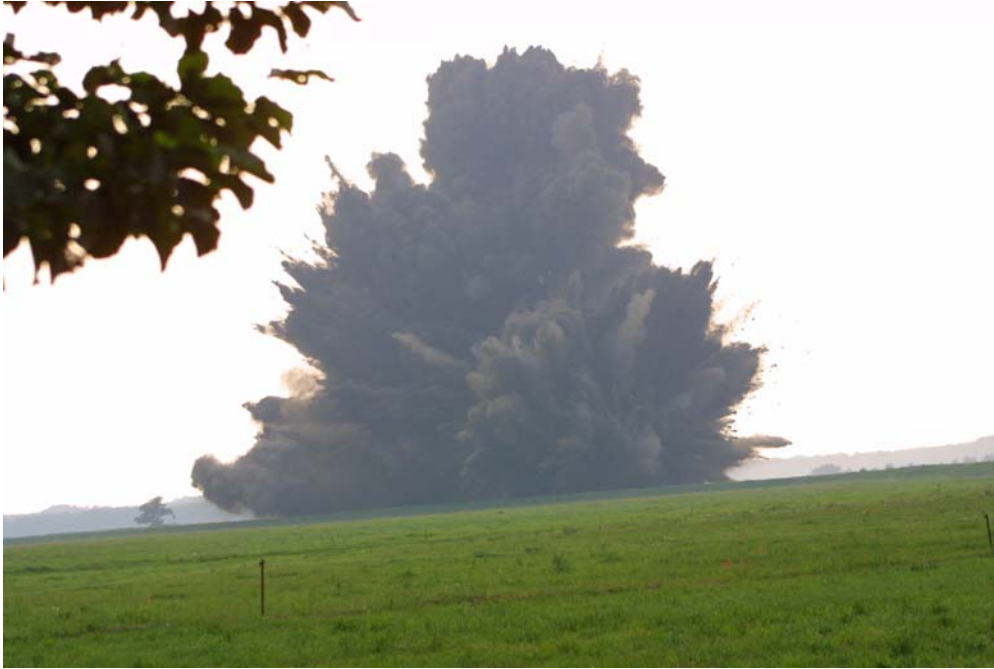
Havelpolder "Flöthgraben" am 22.08.02, 18:45 Uhr: Der Deich wird auf einer Länge von 50 Metern gesprengt.
