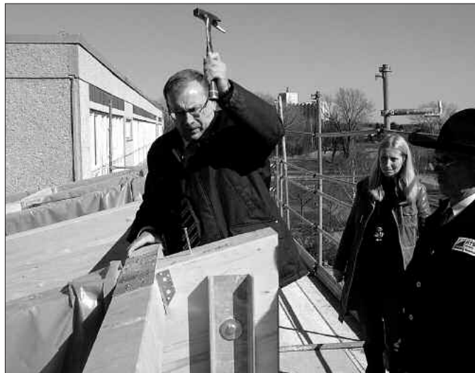
Landrat Klaus Richter bei den symbolischen letzten Hammerschlägen auf dem Dach
