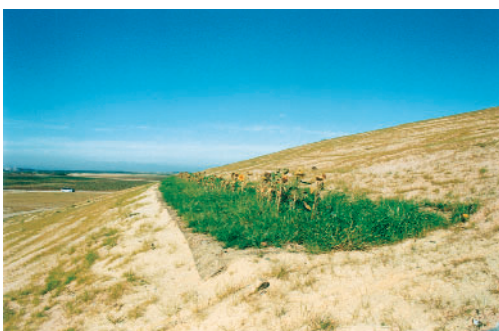
Hangsanierung mit ROFA®
