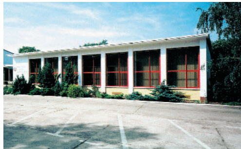
Das IGV-Gebäude in der Arthur-Scheunert-Allee
