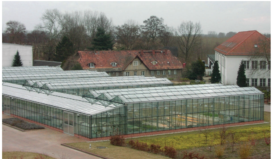
Forschungsgewächshausanlage im IGZ Großbeeren
