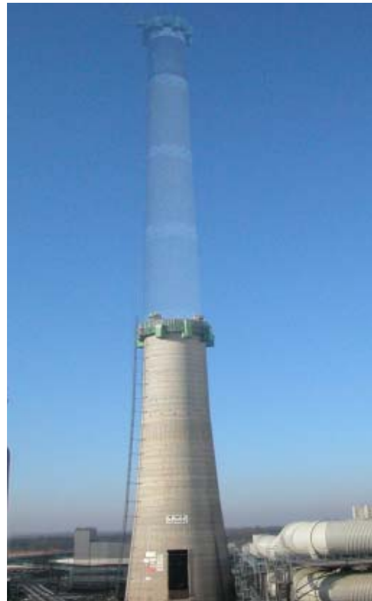
Abbildung 5: Der abgetragene Schornstein
