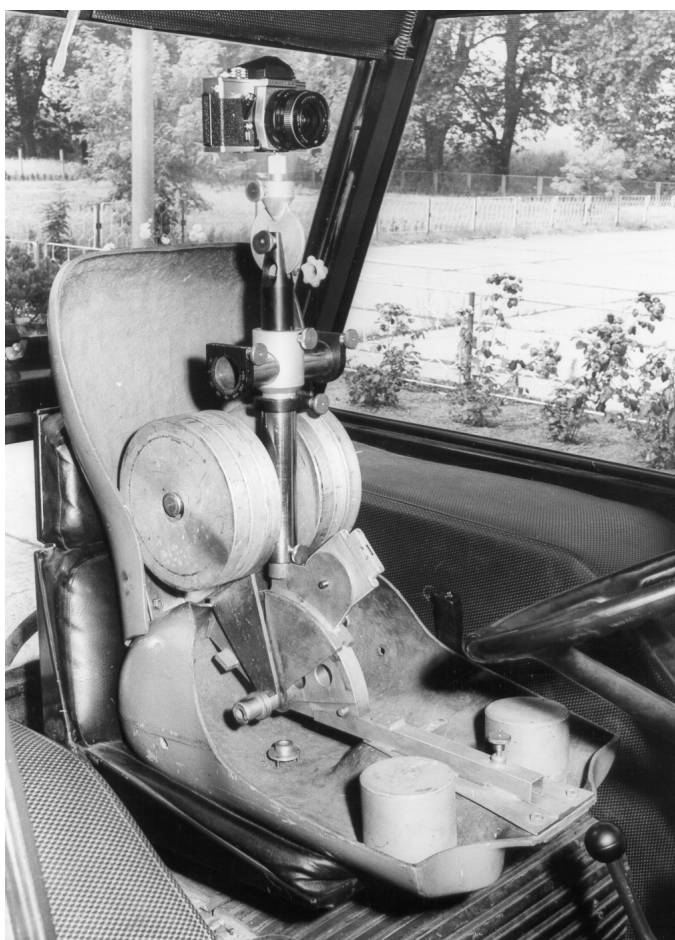
Abb. 10: Prüfpuppe mit Messeinrichtung zur Bestimmung der Arbeitsplatzmaße
