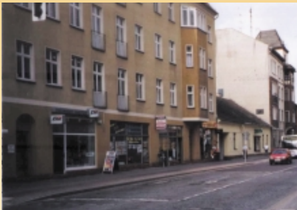
Abb. 6: Situation am Verkehrsimmissionsmesspunkt vor der Fahrbahnsanierung
