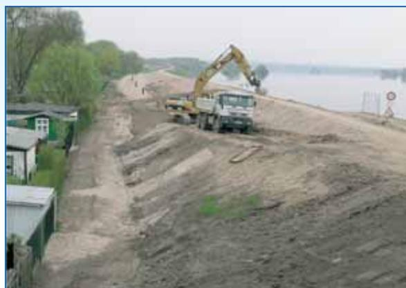
Sanierungsarbeiten bei Deich-km 25+450 im Bereich der landseitigen Böschung (Foto: LUA, M. Oelze 04/2006)
