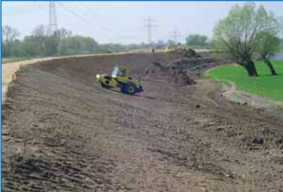
Verdichtung der wasserseitigen Lehmdichtung
