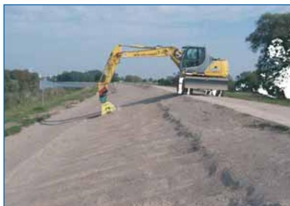
Verdichtungsarbeiten auf der landseitigen Böschung (Foto: Schulze 03/2006)
