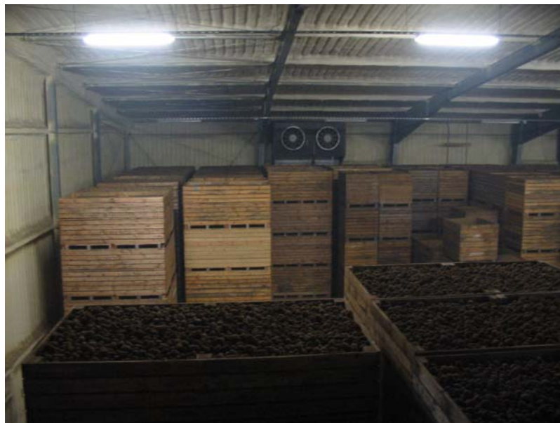
Bild 5.12: Die Gebläse im Kartoffellager Kuhlmann sind über den Kartoffeln angeordnet
