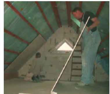
Dachgeschossausbau. Foto: Kati Köllner
