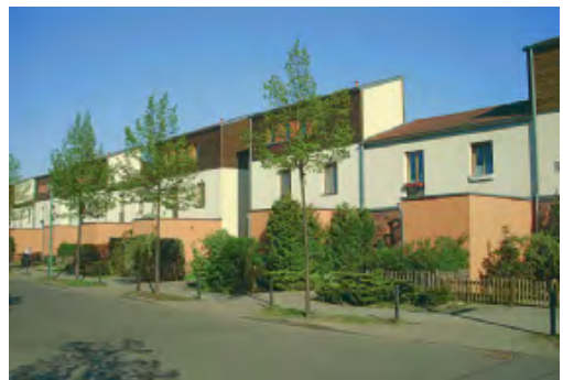
Bei einer Reihenhausbebauung wird typischerweise an die Grenze gebaut. Foto: Kati Köllner
