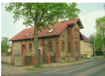
Gebäude mit Abstandsflächen bis zur Straßenmitte. Foto: Kati Köllner
