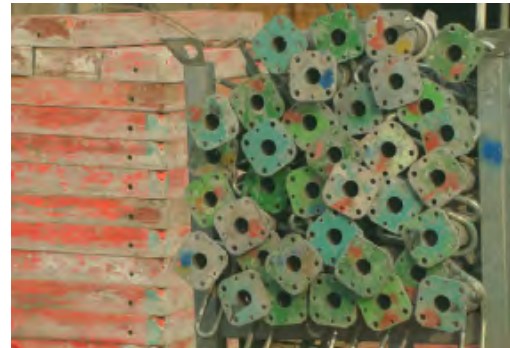
Baustelleneinrichtung. Fotos: Ingo Offergeld
