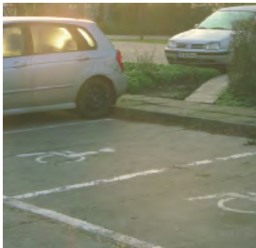
Barrierefreier Hauseingang, Barrierefreies WC, Stellplätze. Fotos: Kati Köllner, Ingo Offergeld
