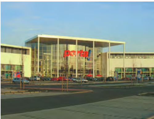
Bei Sonderbauten ist die Prüfung der bautechnischen Nachweise von besonderer Bedeutung. Fotos: Ingo Offergeld, Kati Köllner
