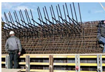
Bewehrung, Foto: LS
