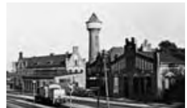
Werkstätten, Wasserturm, Rangierlok August 1979
