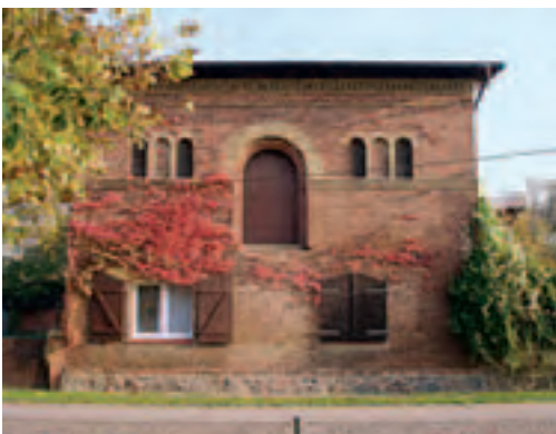
Rohrlack, Kuhstall wird Wohnhaus 2007. Foto Ursula Küchler
