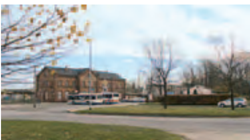
Blick auf den Bahnhof Spremberg
