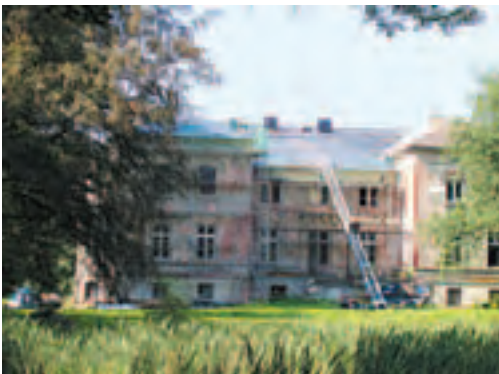
Vichel, das Herrenhaus bekommt ein neues Dach. Foto: Ursula Küchler
