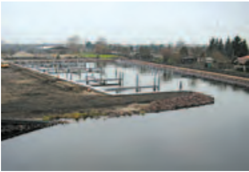
Wasserwanderstützpunkt kurz vor Vollendung, Liegehafe mit den dahinter liegenden Servicegebäuden.
