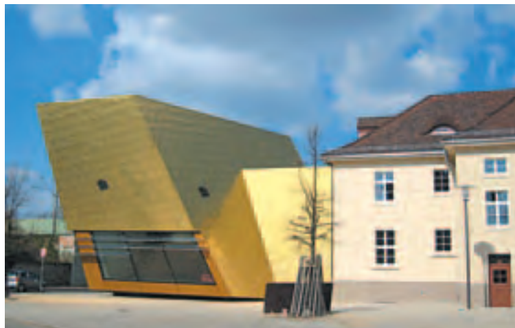
Anbau Kinderbibliothek im Bahnhof Luckenwalde. Architekten: Arge WFF Berlin.
