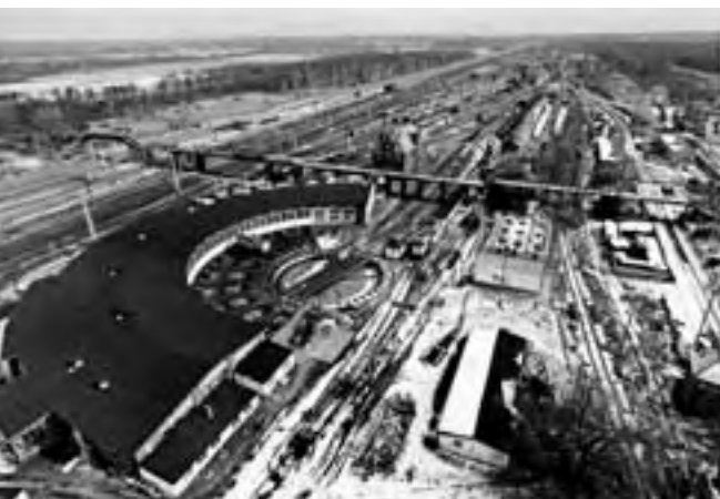
Blick auf den Lokschuppen 1, alte Fußgängerbrücke und Gleisanlagen 1999
