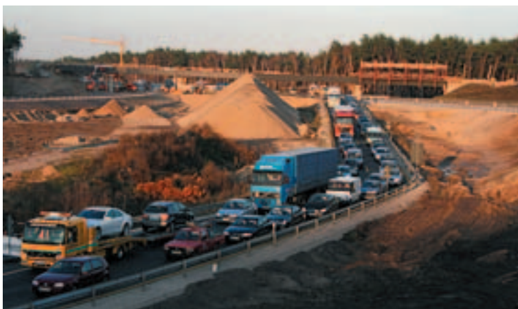
Bauarbeiten am A115 AD Nuthetal, Nov. 2008
