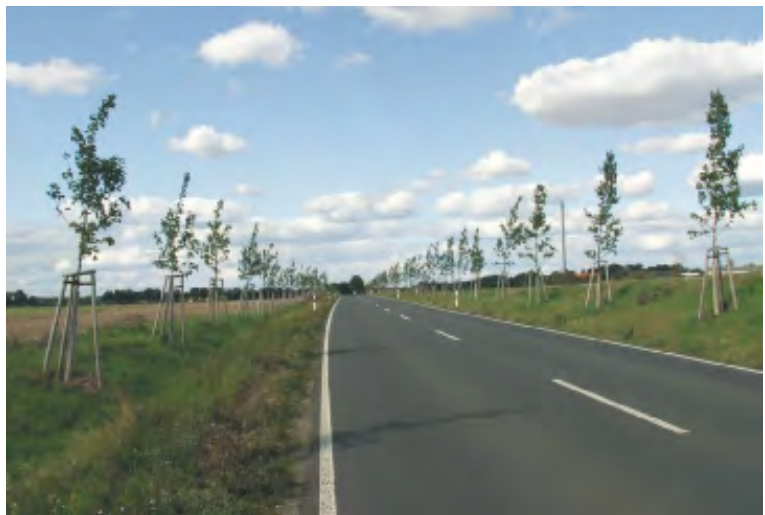
Neuanlage einer Allee an der L 37 (Petersdorf)
