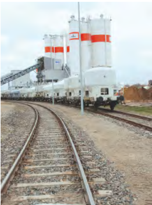
Anschlussbahn zum Zentralen Betonmischwerk zum Großflughafen BBI
