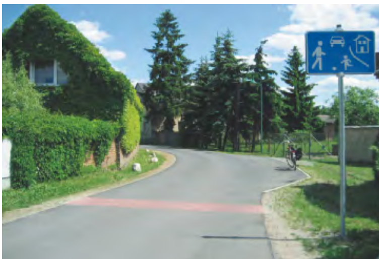
Anliegerstraße Am Ring im Stadtteil Sielow – Fertigstellung November 2007 (Ausbau einer 3,50 m breiten Asphaltbefestigung mit Ausweichstellen)
