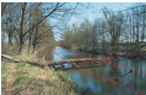
Beschränkung der Beräumung des Totholzes auf den Fahrinnenbereich (Strukturanreicherung mit ökologisch positiven Folgen)
