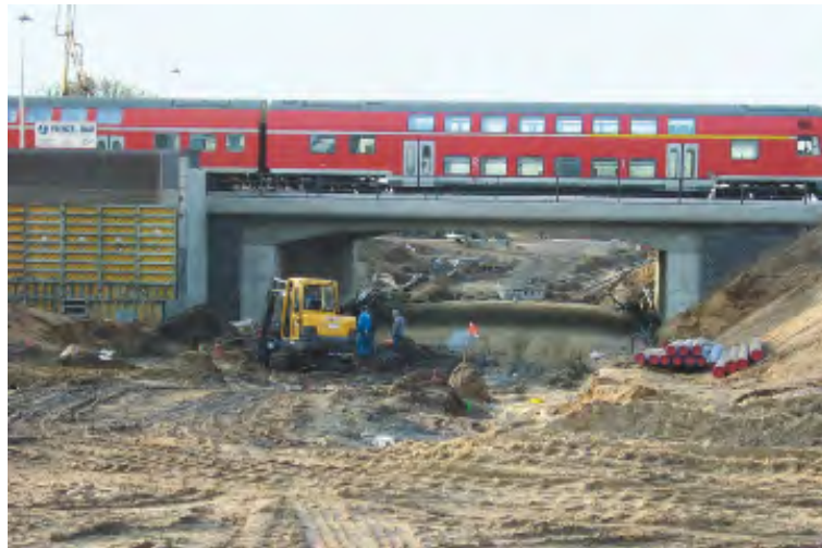
Eisenbahnüberführung im Bau ...
