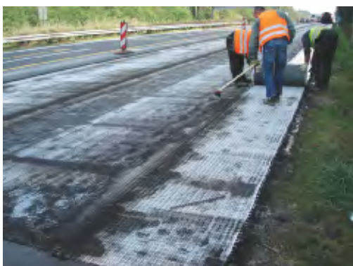
Bewehrung A10 Süd
