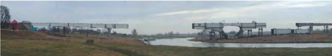
Elbebrücke im Bau
