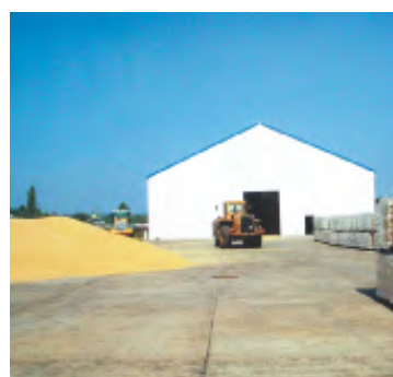
Leichtbauhalle für den Umschlag und die Zwischenlagerung von Holzpellets am Hafen in Eisenhüttenstadt
