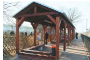
B+R Anlage Wetterschutz kombiniert mit Fahrradabstellanlage in Blumberg
