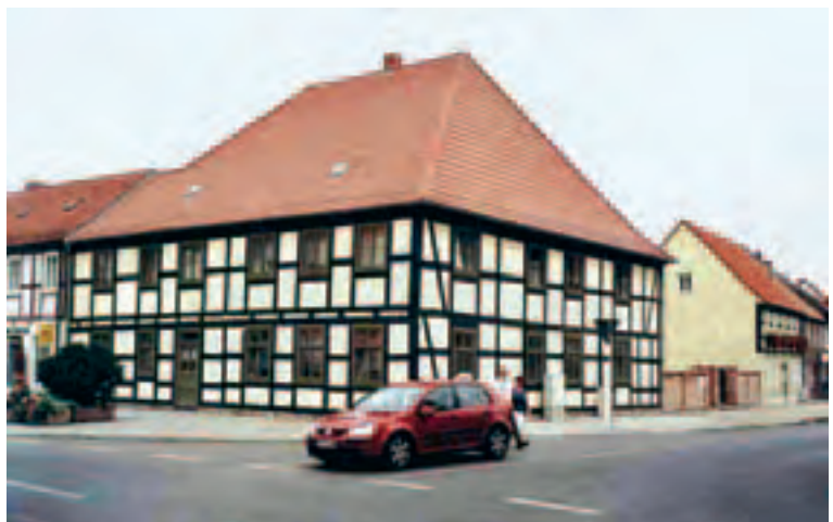
Angermünde, Berliner Str. 2, nach der Sanierung
