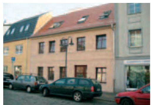
Förderobjekt aus dem Bereich S-WEB: Cottbus, Brandenburger Platz 46 vor ... und nach der Sanierung
