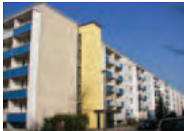
Block nach Anbau des Aufzuges
