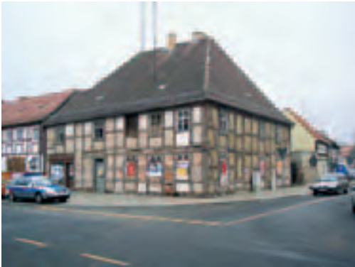
Angermünde, Berliner Str. 2, vor der Sanierung
