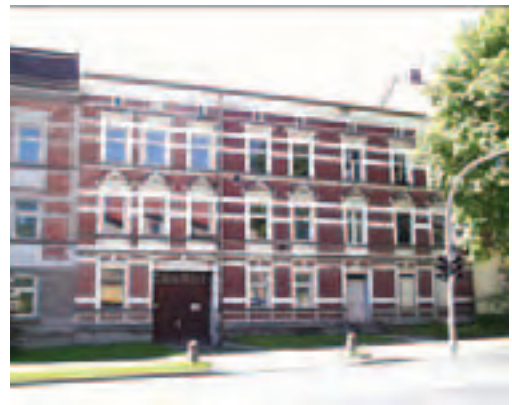
Generationsgerechtes Wohnen in Gründerzeitbauten in der Schwedter Str. 48/50 in Prenzlau über eine Spitzenfinanzierung
