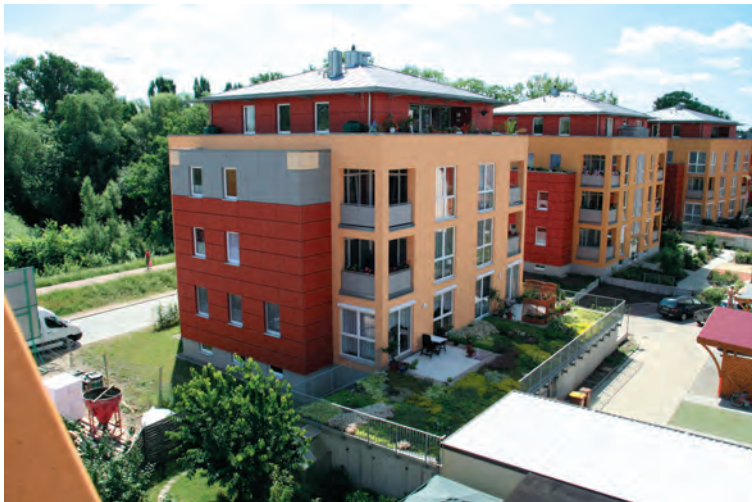
Frankfurt (Oder), Arge an der alten Oder – Südöstliches Stadtzentrum
