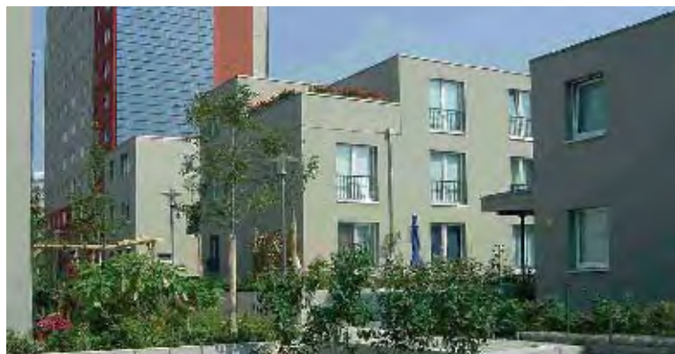
Platte wird Stadthaus – Bau von Stadtvillen aus gewonnenen Plattenelementen eines demontierten Hochhauses.
