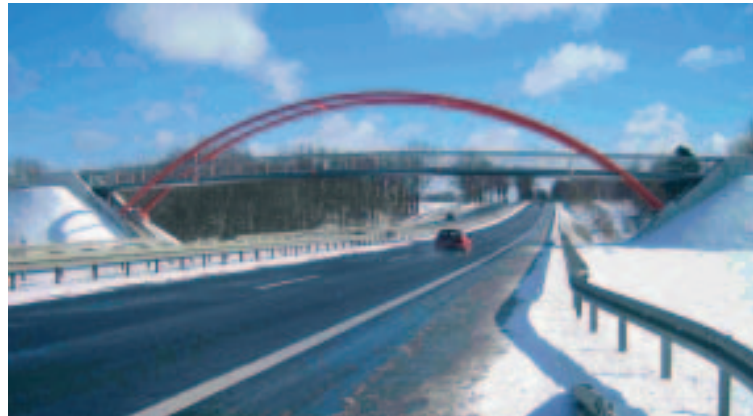
Fußgängerbrücke in Elstal
