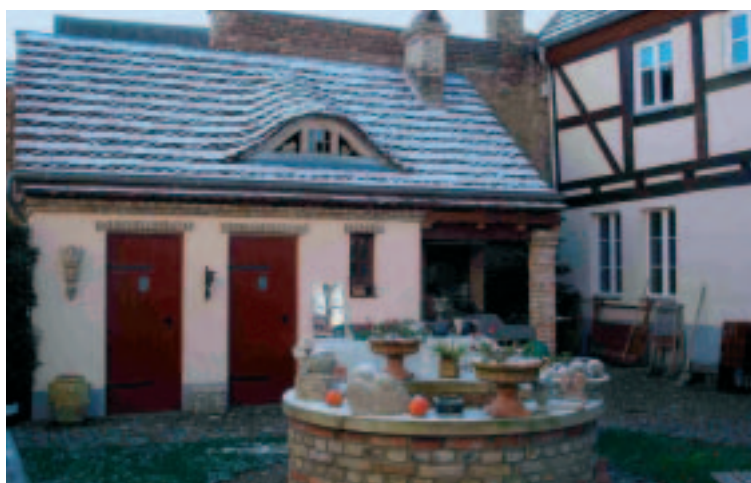
Am Markt 9, Der frei gelegte historische Brunnen aus Feldsteinen und das Hofgebäude mit dem antiquarisch erstandenem Barockdach sorgen für eine einmalige Hofatmosphäre
