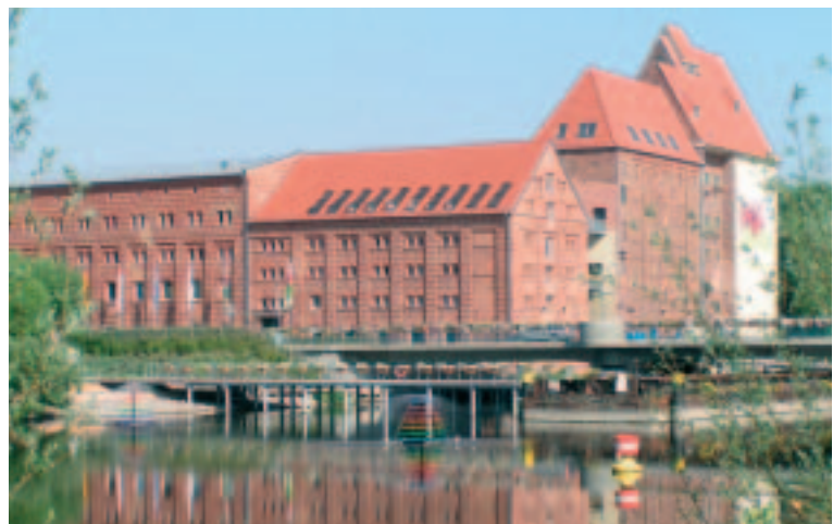
Die Mühle: Zurzeit noch Hauptgebäude der Landesgartenschau 2006 - bald das Haus der Jugend und Musikschule der Stadt.
