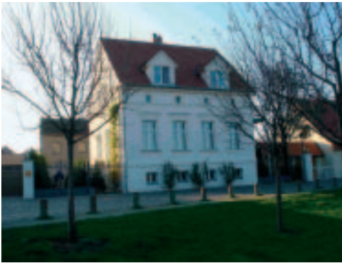
Fischerstr.1, Das frisch renovierte Haus mit charakteristischer Fassade wertet auch die Uferpromenade auf.
