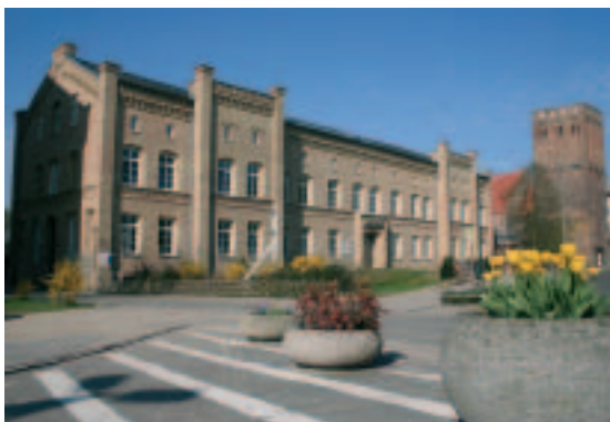
Rathaus nach der Erneuerung mit erweiterten Parkmöglichkeiten
