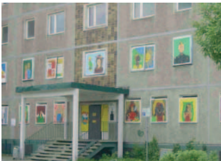
Juni 2005, Jugendliche stellen ihr eigenverantwortlich gestaltetes Projekt "Hochhausfenster" vor. Die mit tristen Verkleidungen gesicherten Fenster der ersten beiden Obergeschosse am Hochhaus Adolf-Hennecke-Str. wurden mit Porträts möglicher Bewohner gestaltet. Ausgewählte Motive wurden zum Logo der Sozialen Stadt in Senftenberg.
