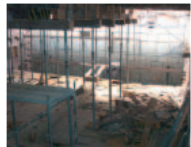
Entfernung Holzstützkonstruktion während des Umbaus.
