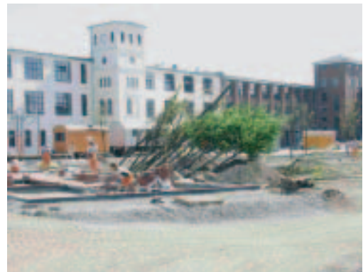
Guben, neues Stadtzentrum
