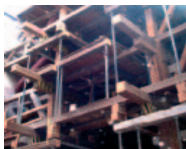
Eng, niedrig und dunkel - das Innere der Mühle vor dem Umbau
