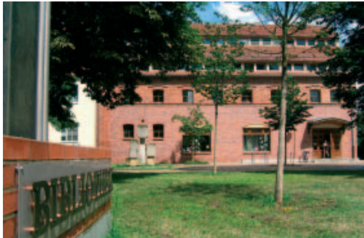
Ausbau des historischen Ermelerspeichers zur städtischen Bibliothek
