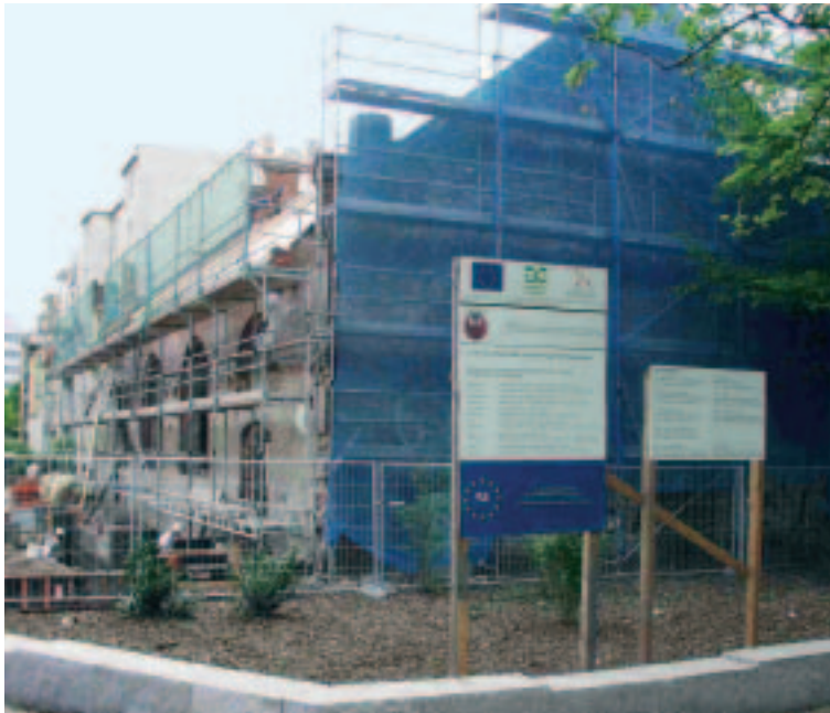
Cottbus, Sanierung der Turnhalle
