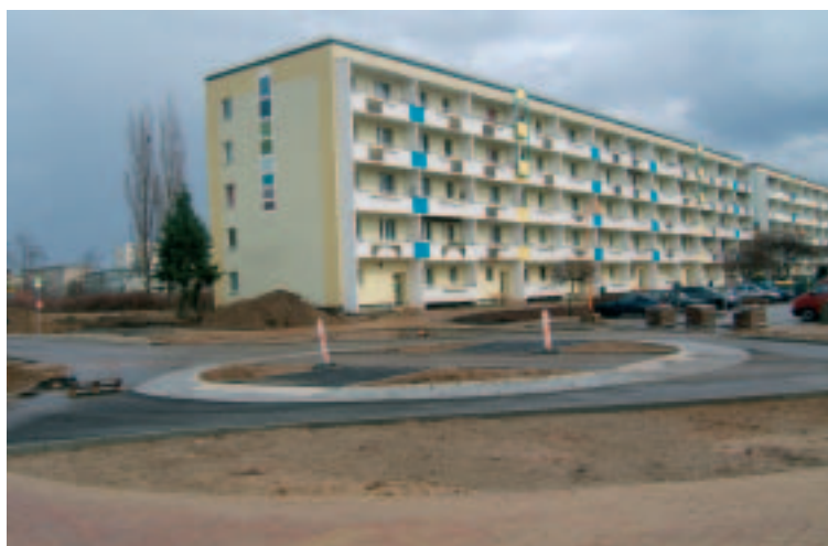
Herstellung eines Kreisverkehrs
