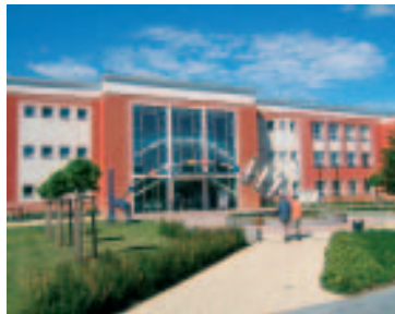
Umbau einer ehemaligen Grundschule zum Verwaltungsgebäude (Fassade und Umfeld)
