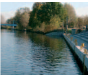
Das neu gestaltete Bollwerk am Landratsamt ist Treffpunkt für die Bewohner und gleichzeitig ein wassertouristischer Anziehungspunkt mit direkter Verbindung zur Oranienburger Innenstadt.
