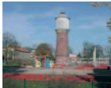
Wasserturm und Sportplatz des Puschkinschulhofs
