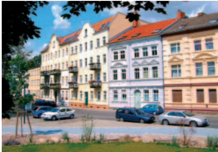
Sanierte Gründerzeitgebäude am Goetheplatz
