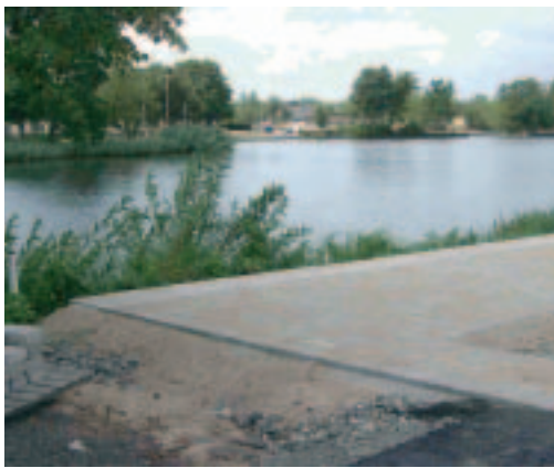
Bauarbeiten im Kanaluferbereich
