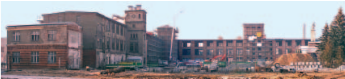
Vorbereitende Beräumungsarbeiten an den altindustriellen Anlagen, Guben, Promenade am Dreieck in 2004
