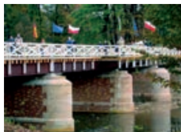
Bad Muskau Grenzbrücke
