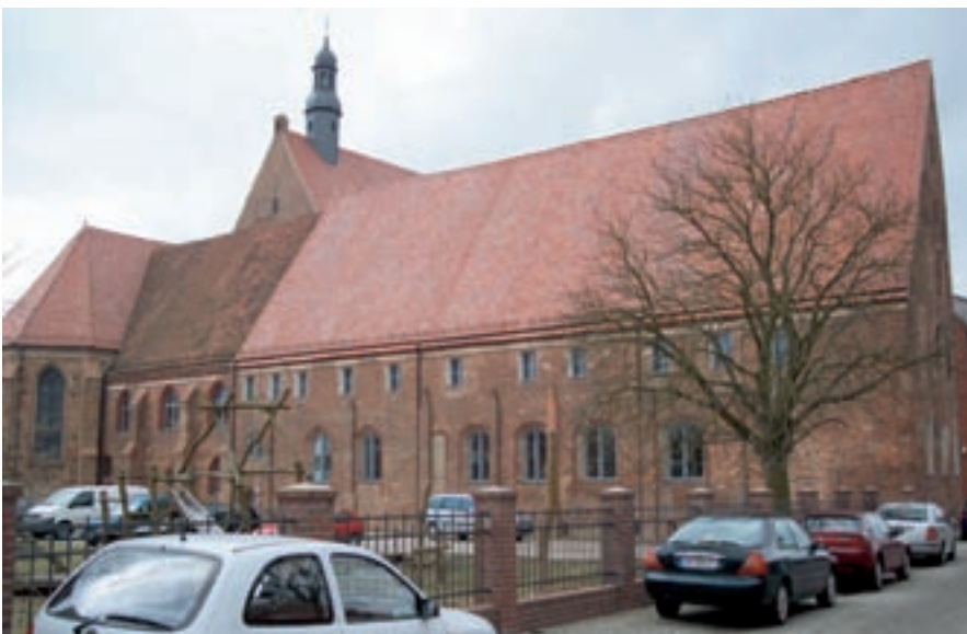
Das sanierte Kulturquartier Mönchenkirche in Jüterbog
