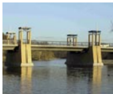
Nedlitzbrücke Neu-Fahrland – Ingenieure: VIC Verkehrs- und Ingenieurbau Consult GmbH, Architekten: JUX-Gruppe
