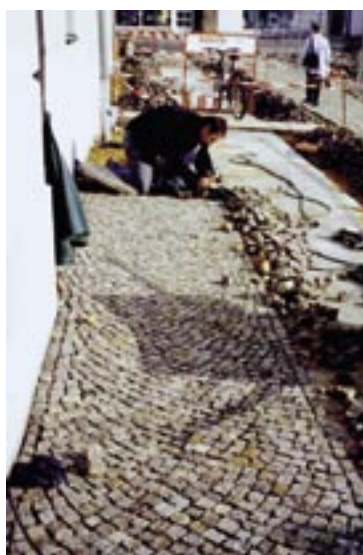
Sachgerecht und in lokaltypischer Netzpasse verlegtes Mosaikpflaster aus Granit mit einem überzeugenden Fugen- und Pflasterbild.
