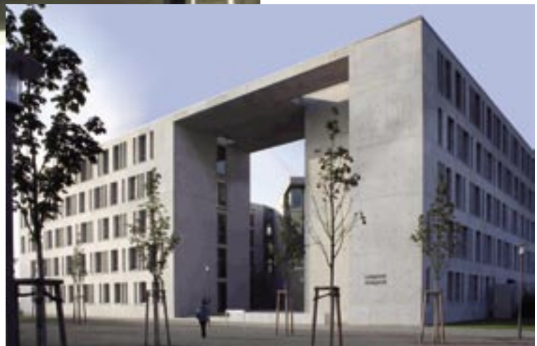
Neubau Land- und Amtsgericht Frankfurt/O., Pichler Ingenieure, Architekten: Bumiller und Junkers Architekten GmbH
