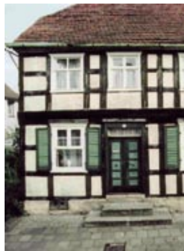
Ackerbürgerhaus, Fassade Vorderhaus vor der Sanierung
