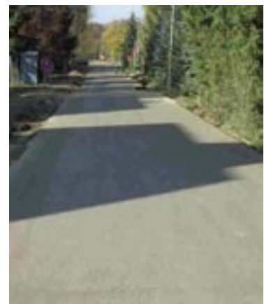
Anliegerstraße Meisenweg nach dem Aufbau
