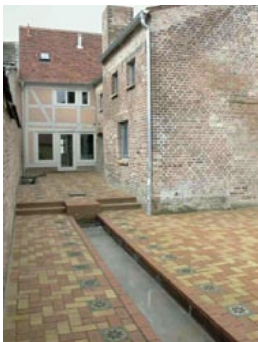
Ackerbürgerhaus Hofsituation vor und nach der Sanierung
