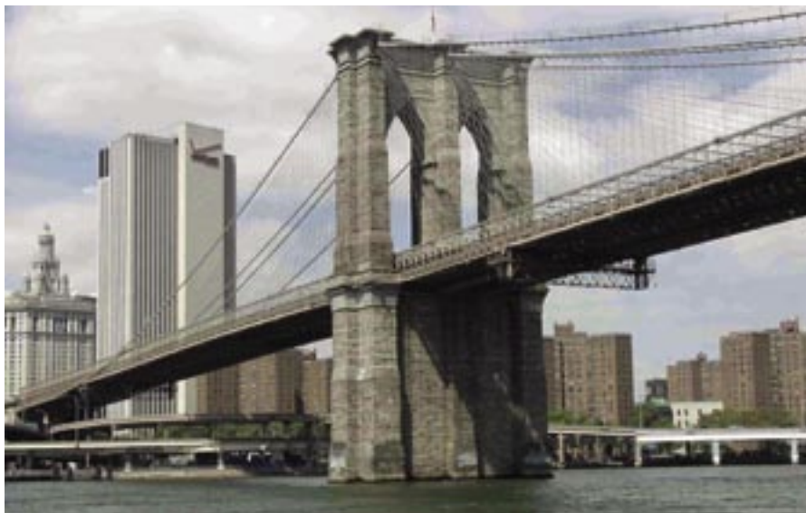
Röblings berühmtestes Bauwerk ist die Brooklyn Bridge. Bau und Fertigstellung sollte er jedoch nicht mehr erleben. Bei den Vermessungsarbeiten zu ihren Fundamenten erlitt er einen Unfall, an dessen Folgen er starb. Ausgeführt wurde die Brücke von Röblings Sohn.
