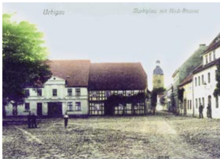
Marktplatz mit der um 1820/25 hergestellten Lesesteinpflasterung. Bis auf die gepflasterten Rinnen als Gosse ist die Platzfläche niveaugleich und ungeteilt.
