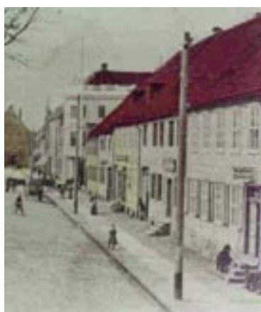
Marktplatz um 1900. Die Funktionstrennung zwischen Fußgänger- und Fahrverkehr durch Anlegen von Bürgersteigen ist erfolgt, und gleichzeitig wurden zur Verbesserung des Gehkomforts Gehbahnen aus Granitplatten angelegt.
