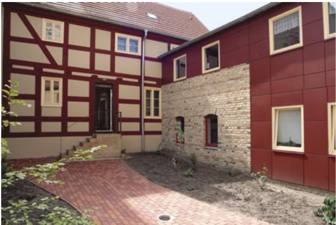
Das Fachwerkhaus in der Gebhardt-Eckler-Straße in Nauen wurde im März 2004 als Denkmal des Monats ausgezeichnet. Das Haus wurde auf den ehemaligen Wallanlagen Nauens errichtet und durch Privateigentümer saniert. Im rückwärtigen Gebäude hat eine gewerbliche Nutzung Platz gefunden. Architektin: Prof. M. Pinardi
