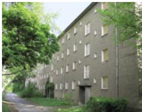
Leer stehendes Wohngebäude, WK I, Rosa-Luxemburg-Straße
