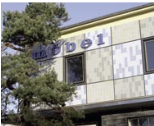
Möbelhaus Lindenallee nach der denkmalgerechten Fassadensanierung (einschl. Werbeanlage)
