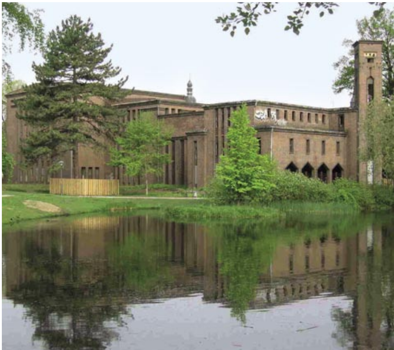
Diesekraftwerk Cottbus, Architekt W. Issel 1926-28
