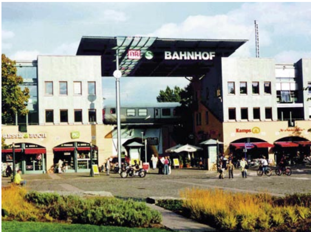
Bahnhof Hennigsdorf, Architekt: K. J. Kaesler
