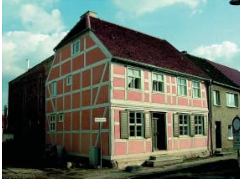
Sanierung eines Ackerbürgerhauses in Wusterhausen / Dosse Architekt: Peter Köster, Rheinsberg
