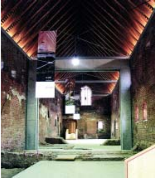
Revitalisierung Kloster Marienstern in Mühlberg / Elbe - Rekonstruktion Refektorium Architekt: Michael Dähne, Dresden
