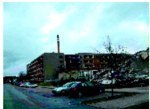
... bei Beginn des Rückbaus im Januar 2003
