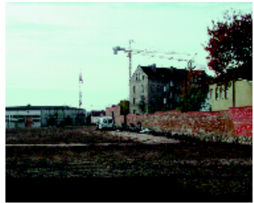
Neuruppin: Beräumte Flächen für die künftige öffentliche Wegeverbindung durchs Seetorviertel
