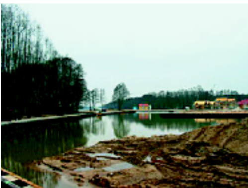
Rheinsberg: Bau des öffentlichen Freizeithafens am neuen „Hafendorf“
