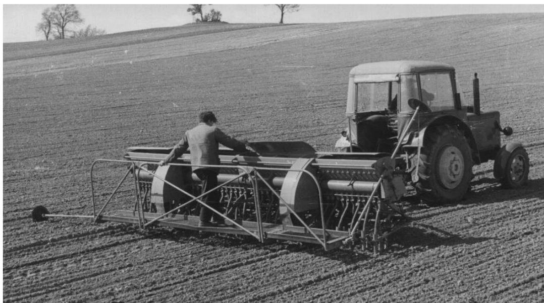
Bild 1: Drillmaschine A 591 mit 5 m Arbeitsbreite
