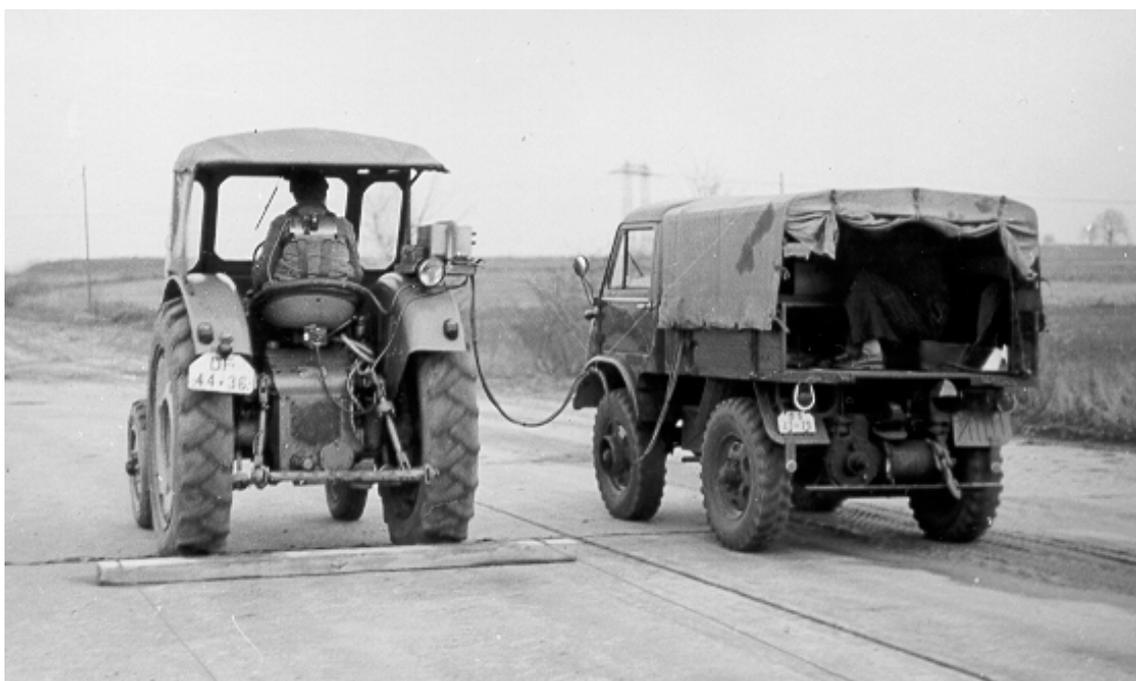
Bild 4: Messungen zur Schwingungsbelastung von Schlepperfahrern
