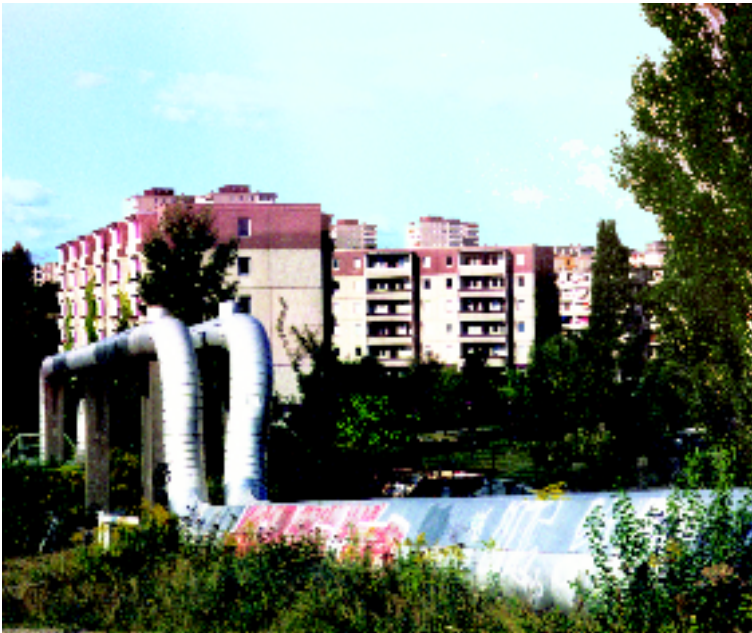
Fernwärmeversorgung in einem Neubaugebiet
