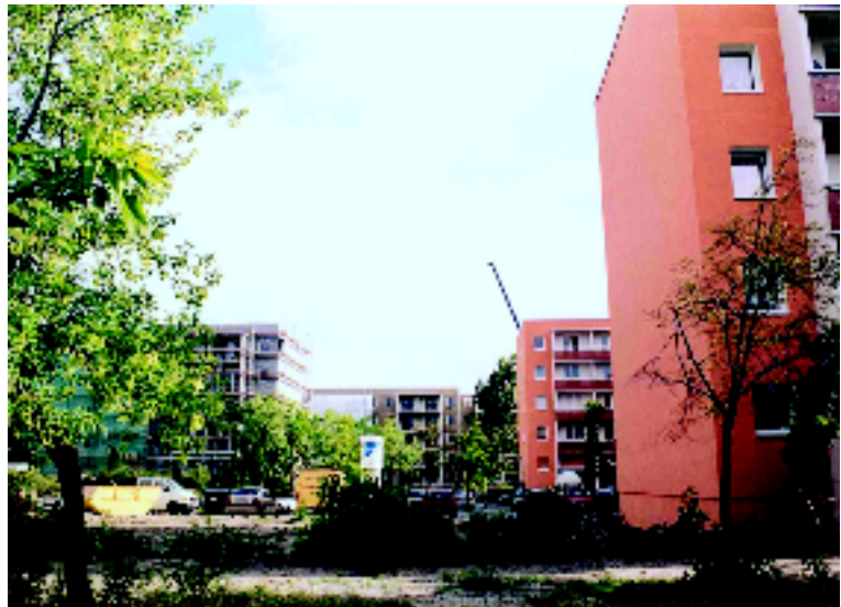
Turower Straße, neu entstandener Durchblick
