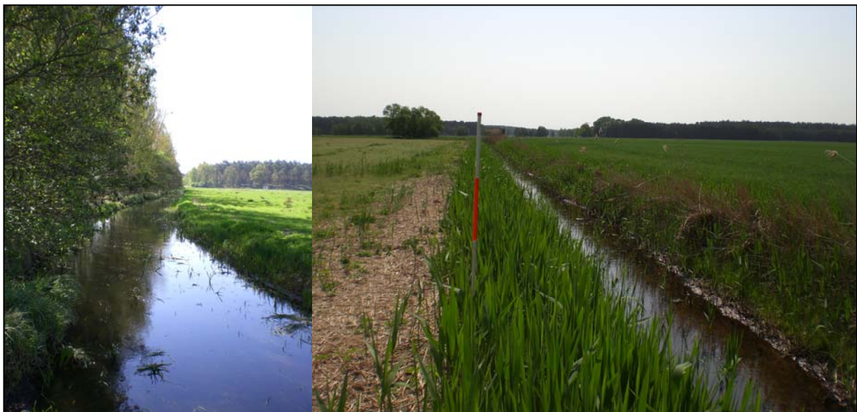
Abb. 35 Begradigter Verlauf des Pfefferfließes, links: in Höhe der Forstbrücke, rechts: vor Frankenförde zusätzlich eingetieft
