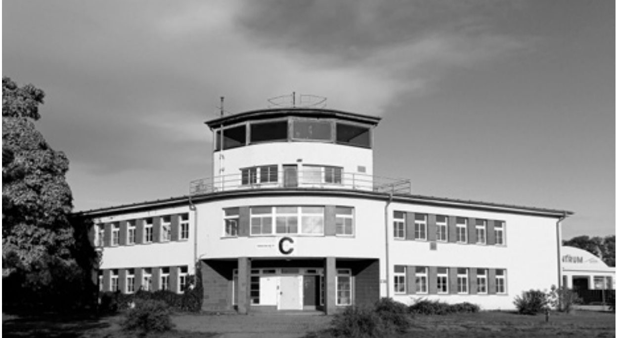
Der Tower des ehemaligen Flugplatzes Cottbus, erbaut 1934.
