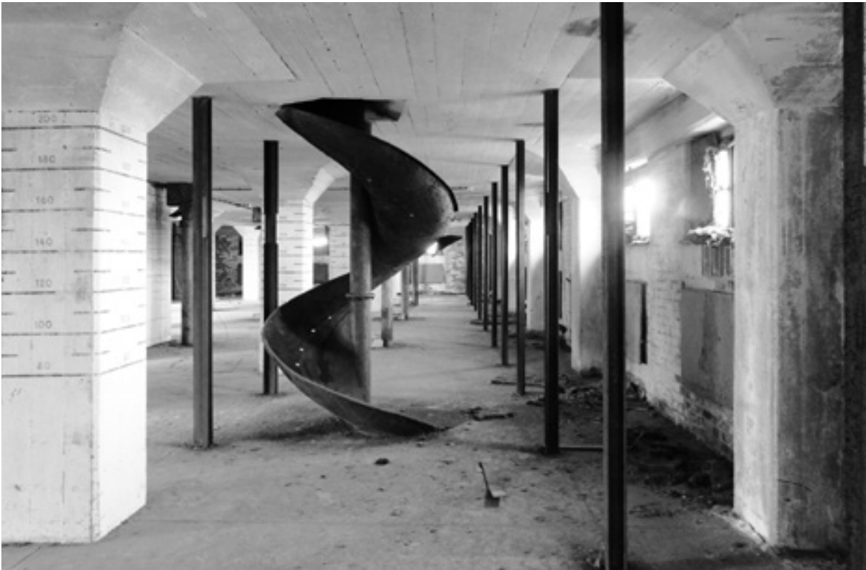
Innenansicht des alten Kornspeichers in Cottbus mit Sackrutsche.
