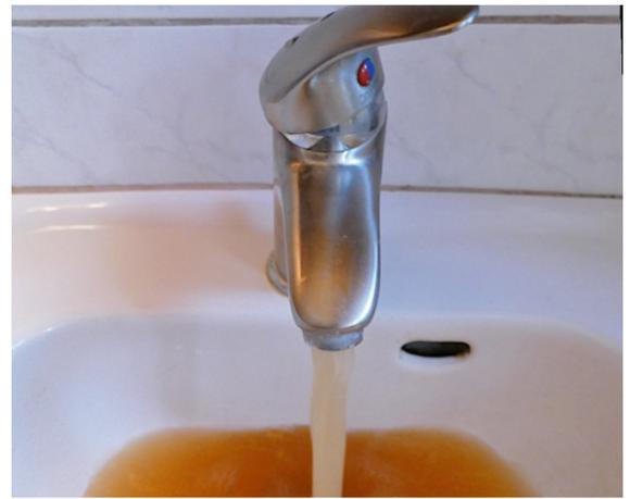
Foto links: In einem modernen Klärwerk (hier: Bülker Huk, bei Kiel) durchläuft das regionale Abwasser drei verschiedene Stufen der Reinigung. Zuerst werden mechanisch Abfälle entfernt, danach erfolgt die biologische Neutralisierung, ehe es wieder in ein Gewässer (hier die Ostsee) geleitet wird. Foto rechts: Rost- oder Mangan eintrübung beim Trinkwasser, Nährboden für Keime.
