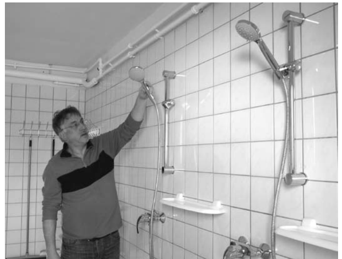
Vereinsvorsitzender Günter Lang bei letzten Handgriffen an der Sanitäranlage.
