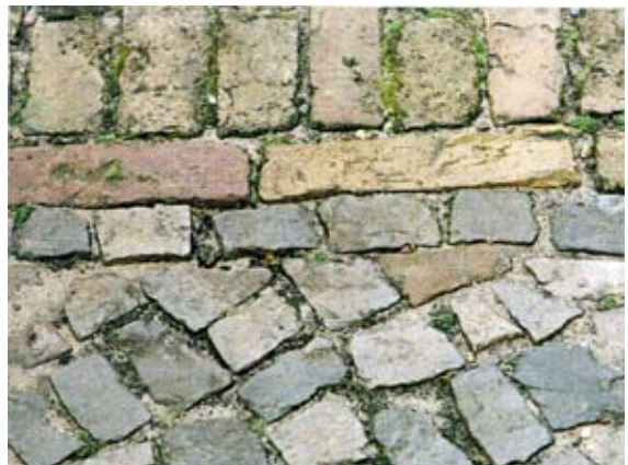
Pflasterwechsel in Ausfahrten
