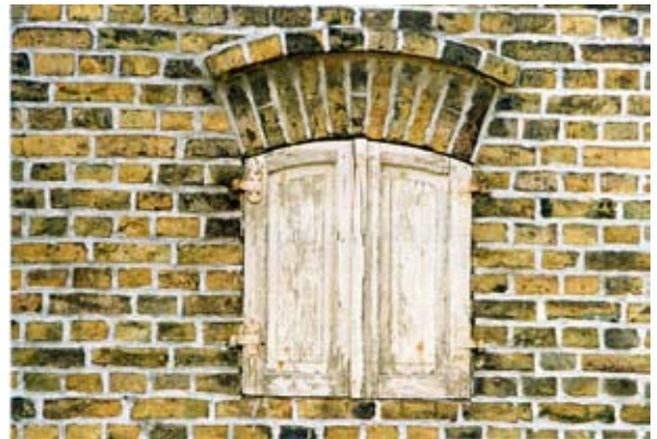
Vorhandene Fensterläden als Vorlage für neu anzulegende Läden § 4 Abs. (6)
