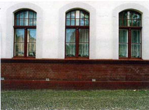
vorhandene Fenstergestaltung § 4 Abs. (5)
