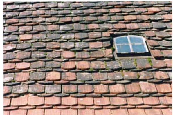
Historische Dacheindeckung, Biberschwanz - Kronendeckung § 5 Abs. (5)
