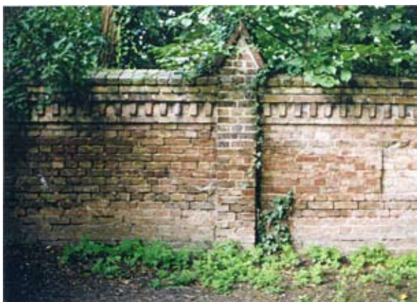
Reich gestaltete Grundstücksmauer § 9 Abs. (3)
