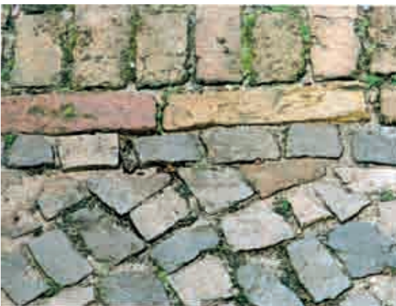
Pflasterwechsel in Ausfahrten
