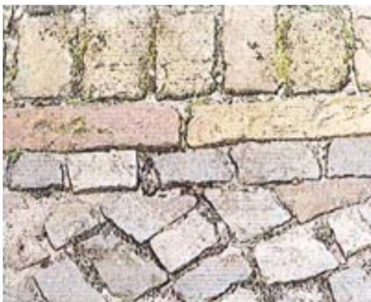
Pflasterwechsel in Ausfahrten
