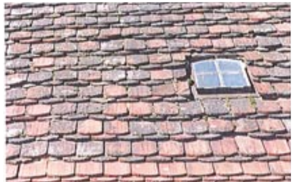
Historische Dacheindeckung, Biberschwanz – Kronendeckung § 5 Abs. (5)
