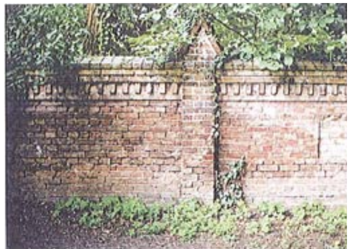
Reich gestaltete Grundstücksmauer § 9 Abs. (3)
