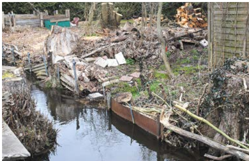
Vermüllung und Einengung des Stobberfließes durch Uferverbau verhindert einen langsamen, natürlichen Abfluss
