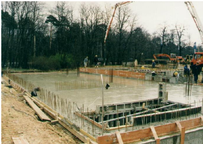
03.03.1997 Fundamente werden gegossen
