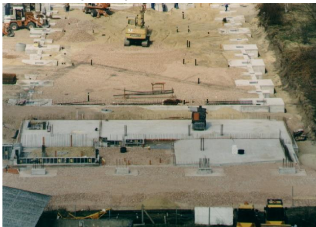
02.04.1997 Tag der Grundsteinlegung Grundplatte Verwaltungsblock mit Lst.
