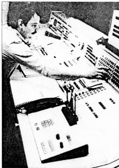
Vor zehn Jahren: 1989 arbeitete die Leitstelle in Cottbus mit dem Empfangsgerät NRS 69, damals Stand der Technik. Oben sind Melder-schrank sowie städtische Feuermelder um 1970 zu sehen.
