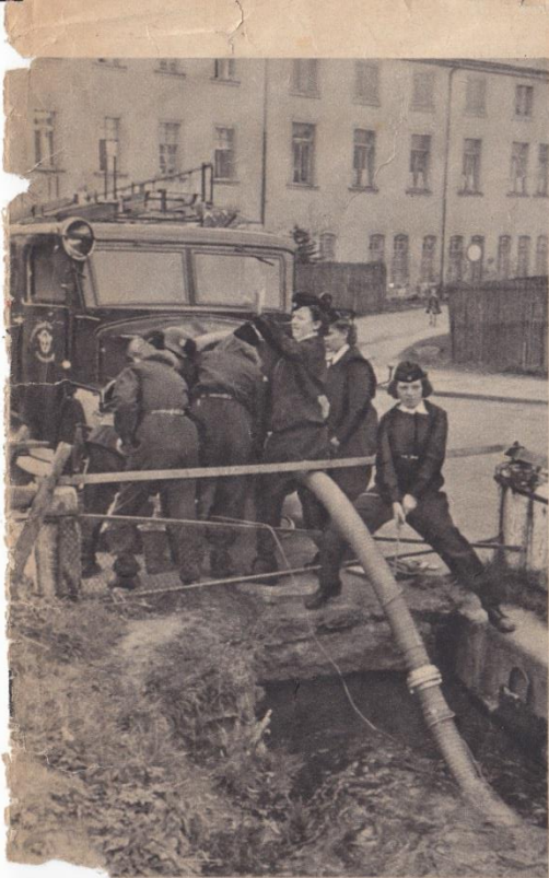
Bei den Übungen lernen die Frauen die Geräte bedienen. Hier wird das Löschwasser mit der Kraftspritze aus einem nahe liegenden Gebirgsbach entnommen
