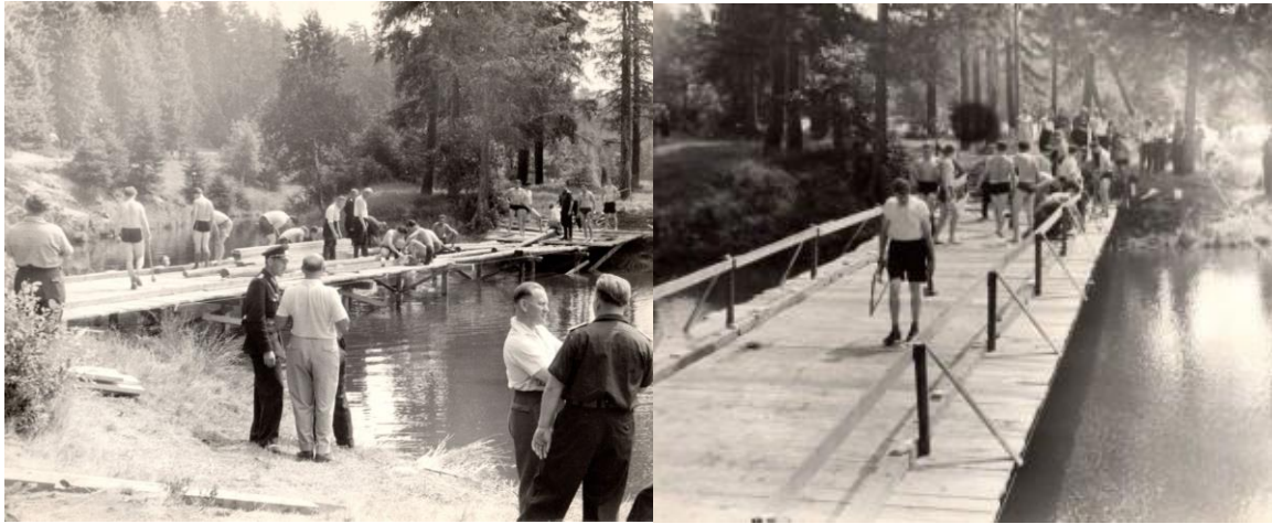
Übung eines Bauzuges: Bau einer Behelfsbrücke von 25m Länge und einer Tragkraft von 4 t (Fw Eiffeld)
