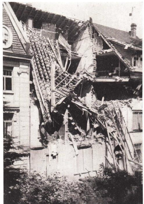
Am 17. August 1917 zerstörte eine französische Sprengbombe dieses Haus in Freiburg i. Br. Die Bombe, wahrscheinlich von einem Gewicht von 50 kg, freipierte im Hause. Die Flughöhe des Angriffsschwaders betrug angeblich 3000 m. Das Bild belegt treffend die Notwendigkeit der Einrichtung von Schutzeinrichtungen.
