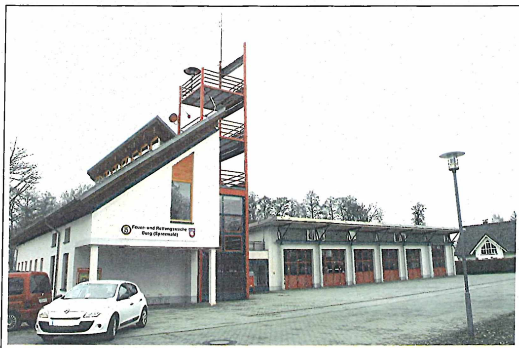
Neue Feuer- und Rettungswache der Amtsfeuerwehr Burg Foto H.-D. Unkenstein 16)
