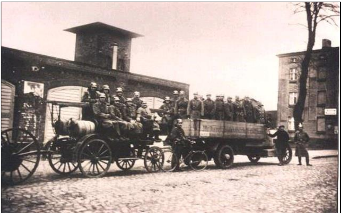
Abbildung: Mannschaft und der Technik der FF Gützkow ca. um 1925 [entnommen von der Internetseite der FF Gützkow http://www.Feuerwehr-Gützkow.de ]
