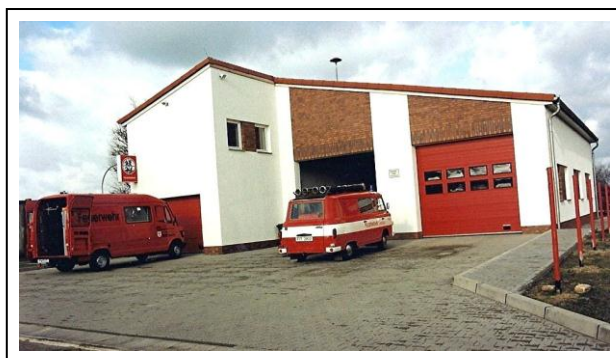
Gerätehaus Ansicht von Westen
