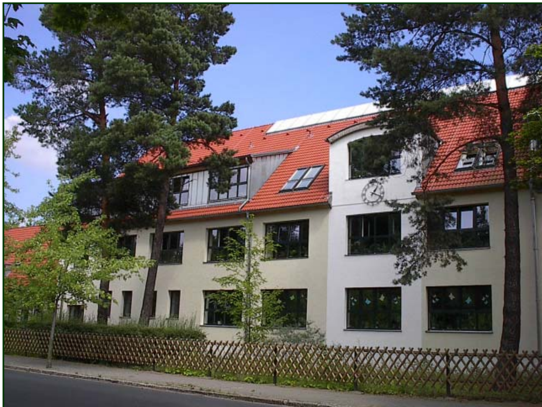
Bild 167: Das neue Schulhaus (Straßenseite)
