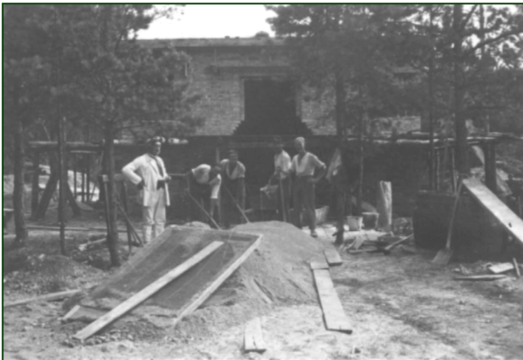
Bild 22: Helfer beim Bau am 01.08.1931
