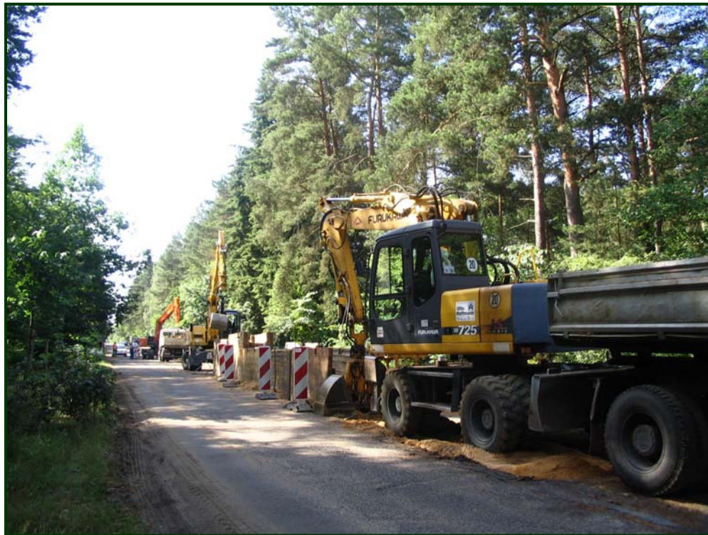
Bild 159: Abwasserverlegung in der Wilmersdorfer Straße
