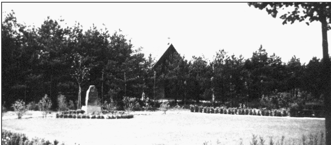
Bild 75: Kirchengrundstück von der Berliner Straße aus gesehen
