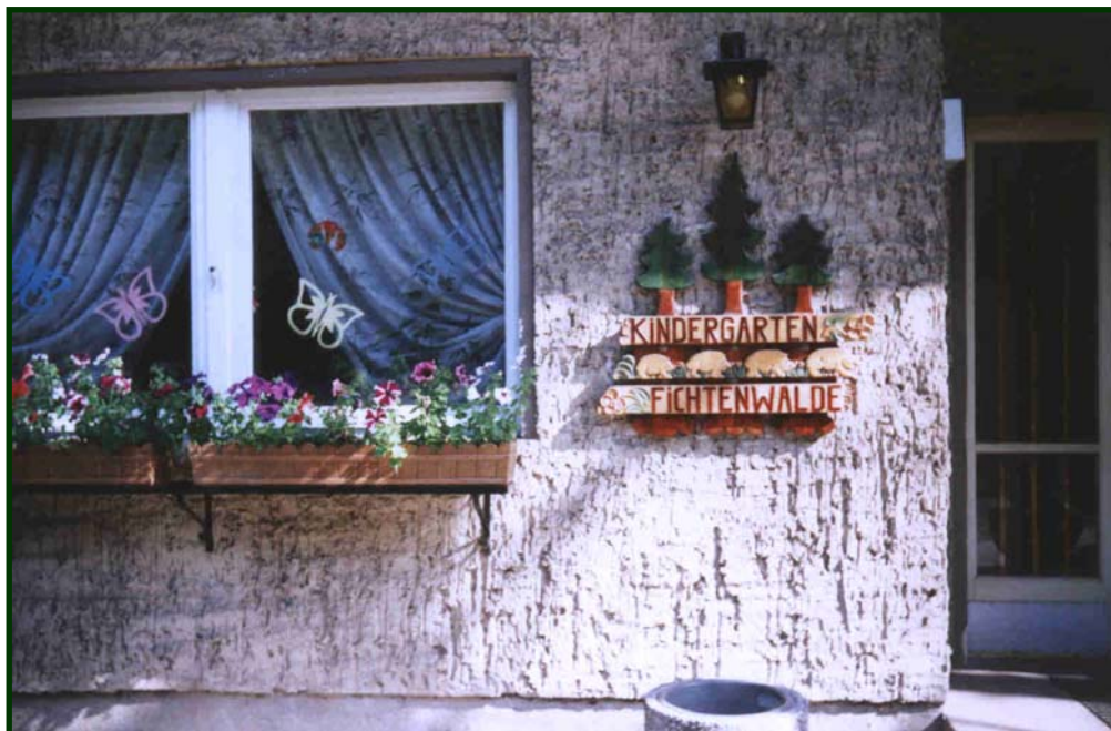
Bild 116: Eingang zum neuen Kindergarten
