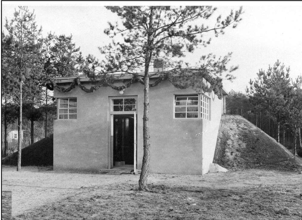
Bild 23: Das fertige Maschinenhaus des Wasserwerkes 1931
