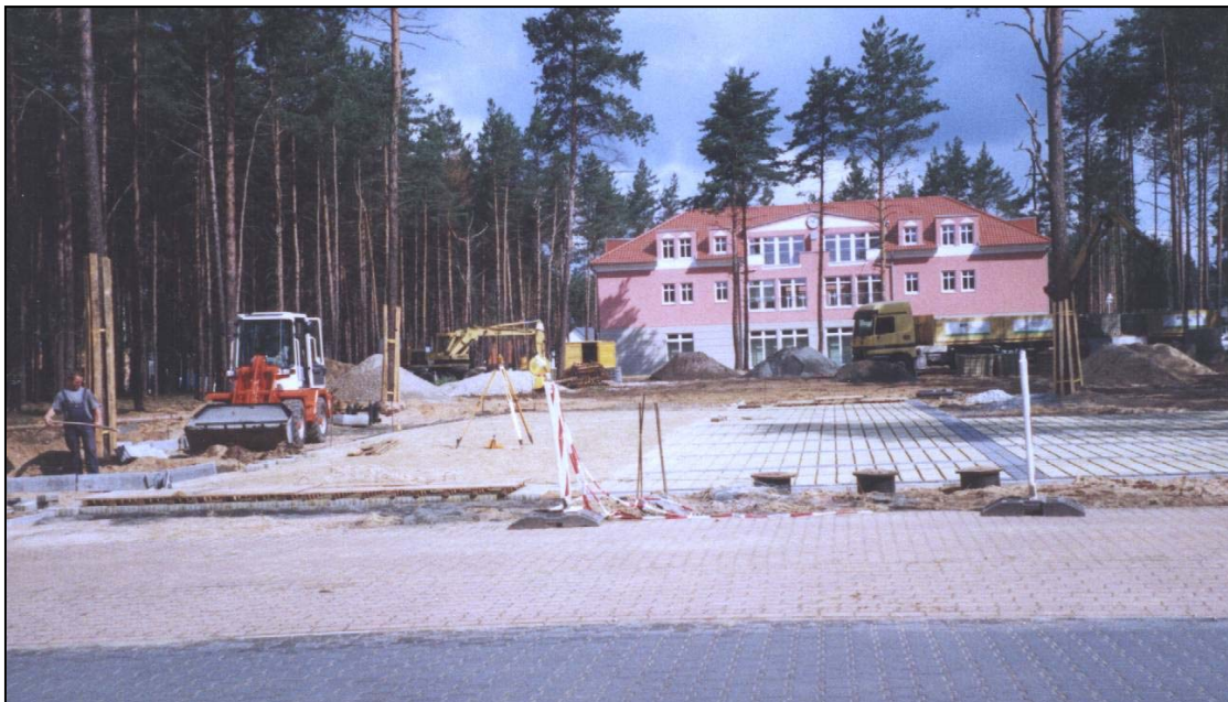
Bild 150: Im Juni 2001 wird der Autostellplatz für die Bewohner gepflastert
