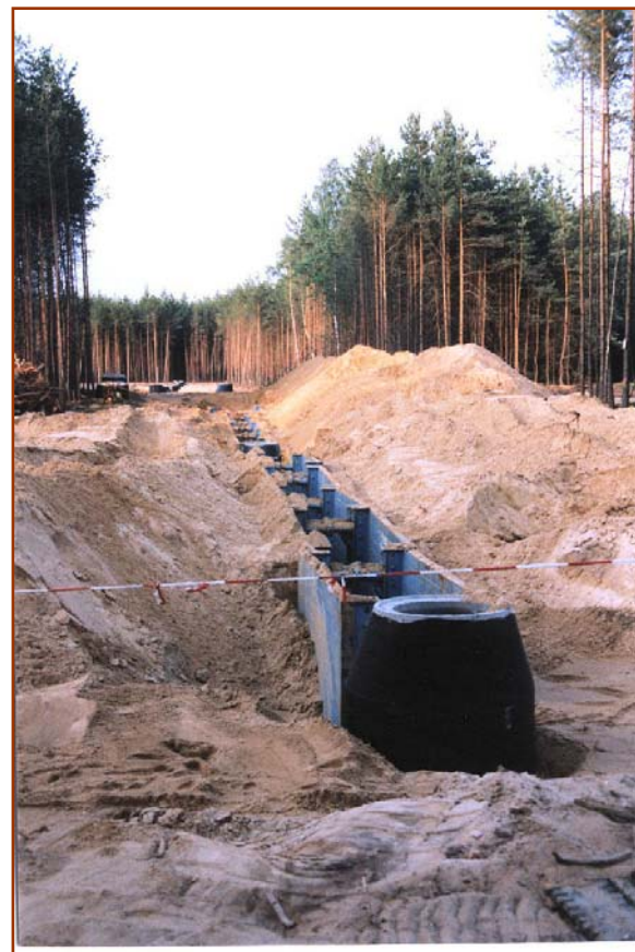
Bild 145: Bau der Kanalisation
