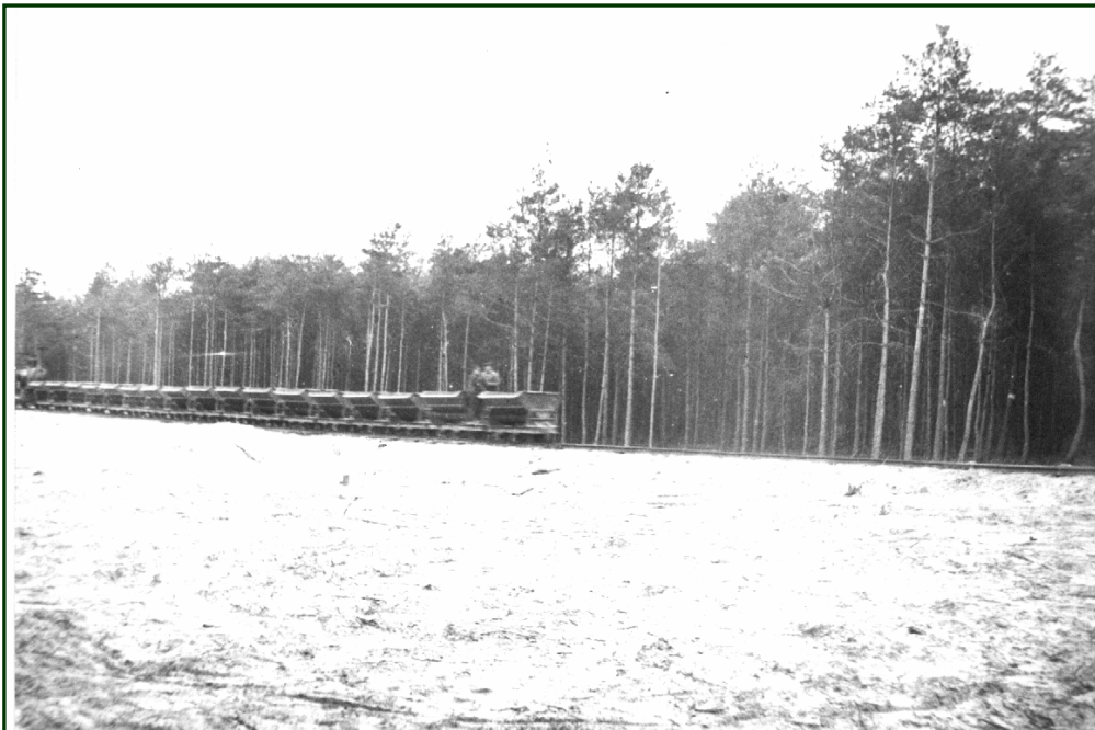
Bild 70: Der Lorenzug (17 Loren) auf der bereits geplanten Autobahntrasse
