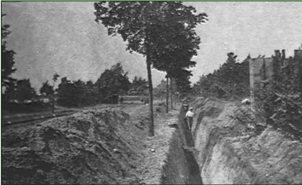
Bild 125: Der Rohrgraben vor dem Rummelsborner Weg
