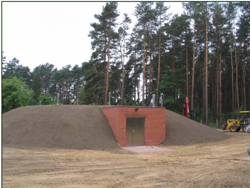
Bild 156: Der neue Trinkwasserbehälter
