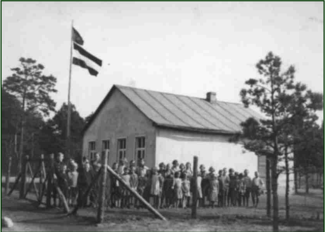
Bild 41: das bereits verputzte Schulhaus
