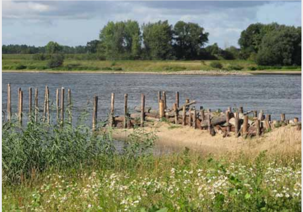
Zurück zu den Wurzeln: Totholzbühne im Bau, Sommer 2008 (Foto: Archiv Biosphärenreservat)
